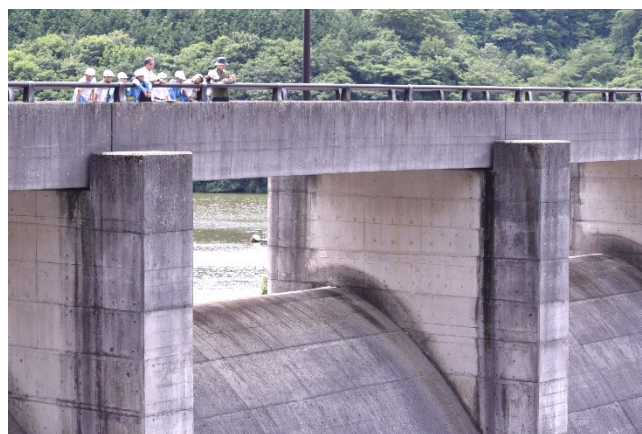
【4年生】7/3 浄水場・ダム見学
